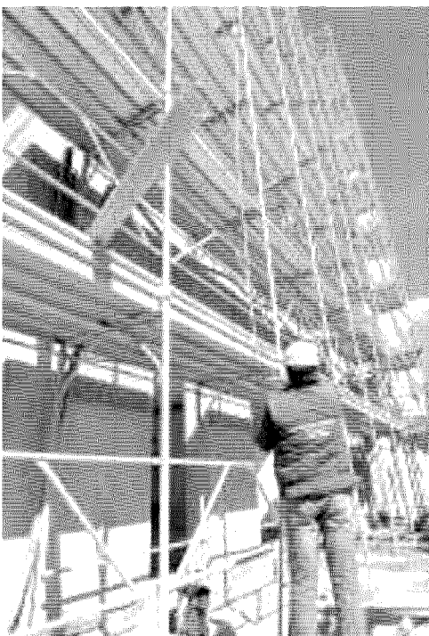
Un cantiere edile
