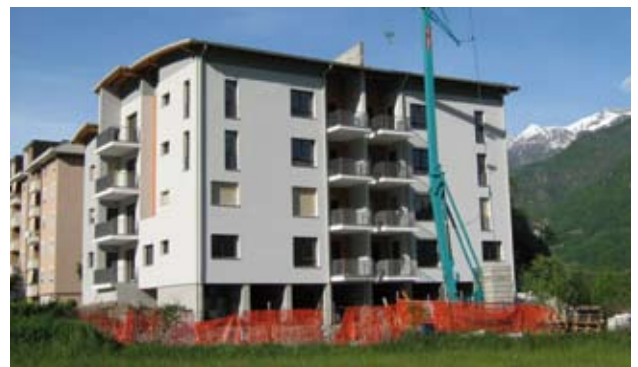
1. inquadramento territoriale del progetto 2. foto di cantiere 3. foto di cantiere
